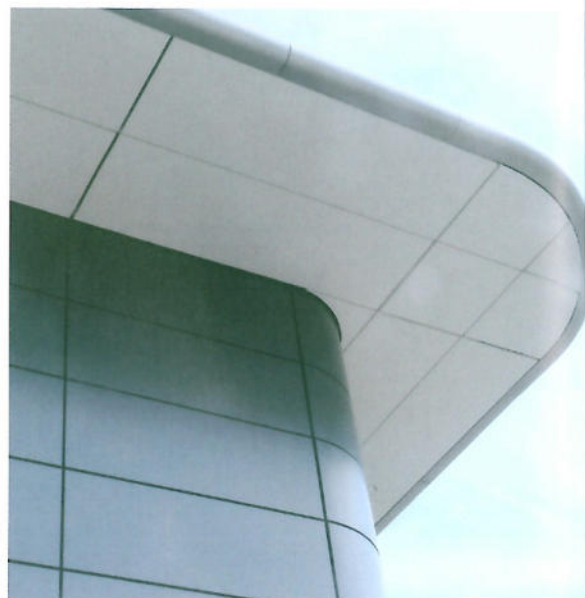
Innovativer Fassadenbau für den Showroom.
