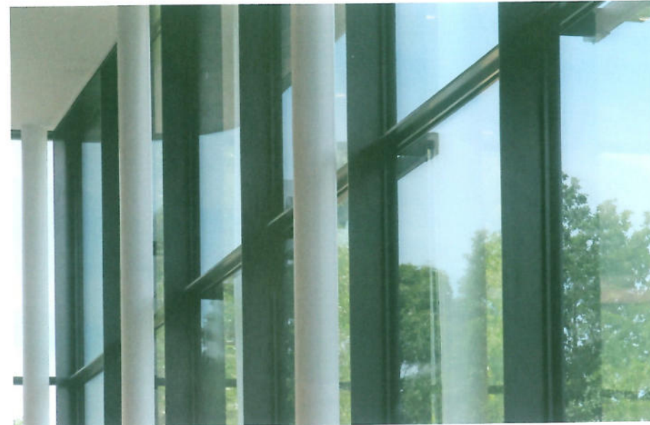
11 Meter hohe Profile sind für eine Glasfassade eine besondere Herausforderung.
