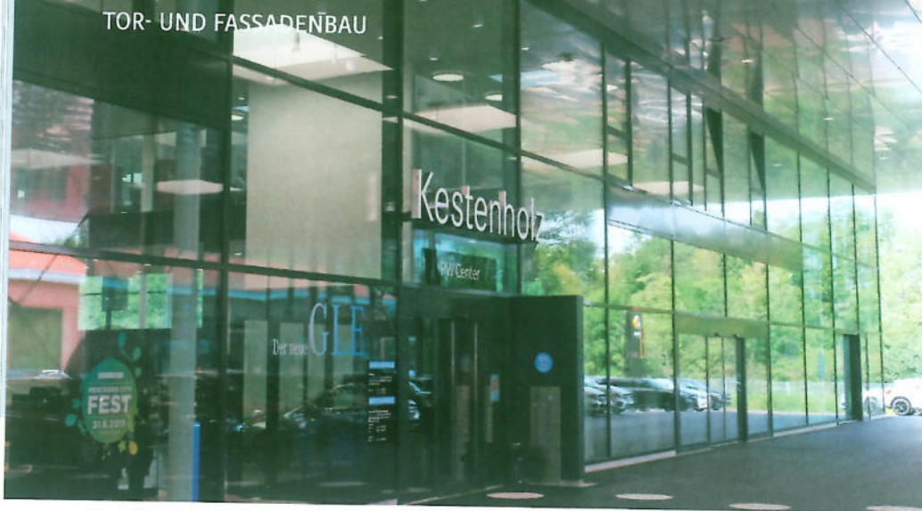
Die T-förmigen Pfostenprofile sind durchgehend geschweisst. Hier mit eingesetztem Türelement. Les profilés de poteaux en forme de T sont soudés en continu. Ici, avec un élément de porte inséré.
