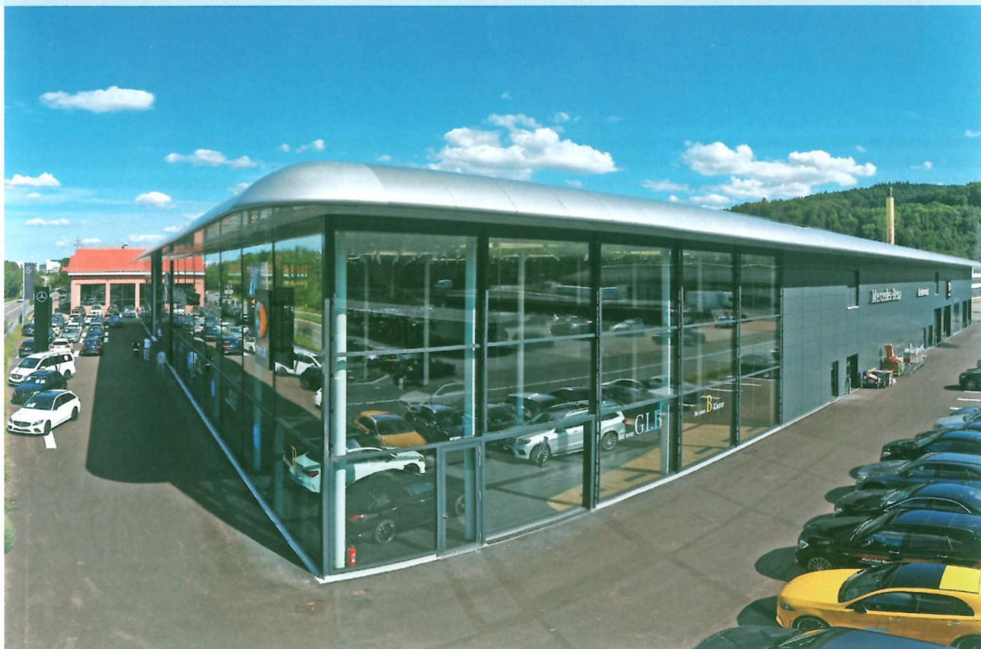
Grosse Glasfelder und filigrane Profile prägen die Fassade des neu erstellten Mercedes-Verkaufsraums in Kestenholz. De grands panneaux vitrés et de minces profilés caractérisent la façade du nouvel espace de ventes Mercedes à Kestenholz.
