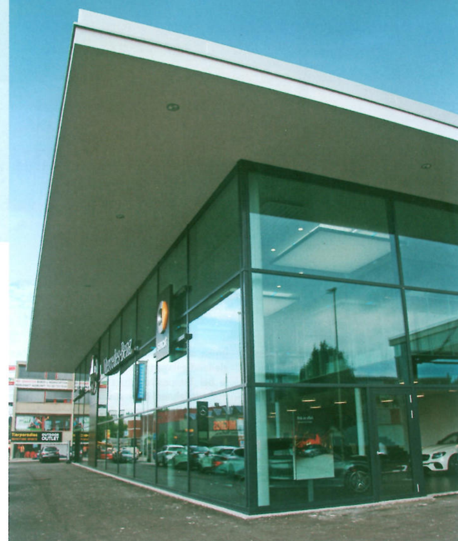
Die Pfosten-Riegel-Fassade ist unten abgestellt und oben gleitend gehalten. La façade poteaux-traverses est posée en dessous et maintenue en haut de façon coulissante.
